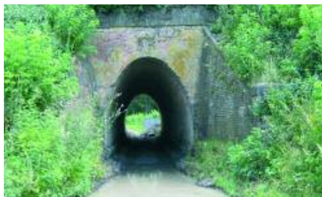
Livenka Il sottopasso della ferrovia
