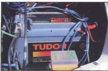
Una delle due batterie dei servizi.
